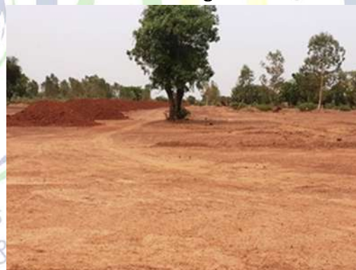
Photo B : butte arrasée par le passage du Bulldozer
