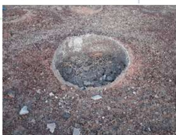
B : détérioration d'un bord de puits
