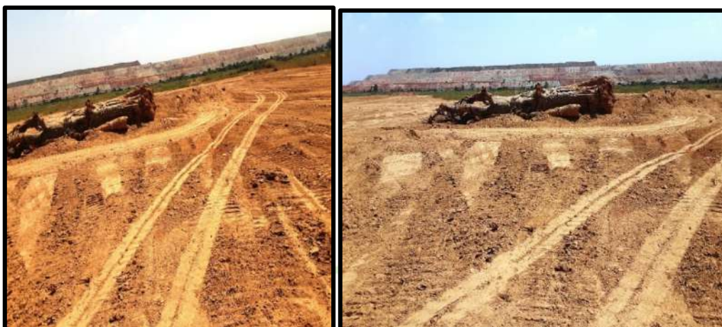
Figure N°5 : vue d'ensemble du site déjà détruit avant cette étude. Cliché YOGO, Bouly octobre 2022
