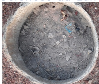
B : détérioration d'un bord de puits C : des déchets à l'intérieur d'un puits
