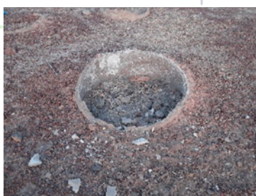
B : détérioration d'un bord de puits C : des déchets à l'intérieur d'un puits
